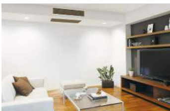
据付必要寸法：高470・幅1,550・奥行850mm以上
