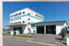
第三工場・第四工場
