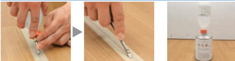
\*注入する液量目安はマスキングテープ上に溶液が約5mm巾で溢れる程度です。
