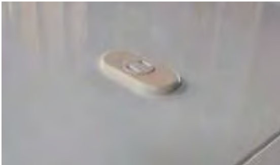
35 セミ多段天埋め込みコンセント
